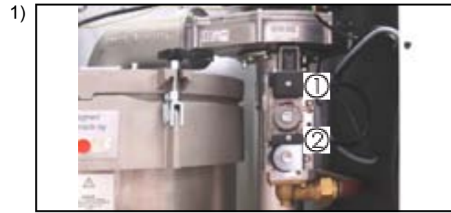
1) Stecker ①② abziehen (vorher Kreuzschlitzschrauben lösen)
