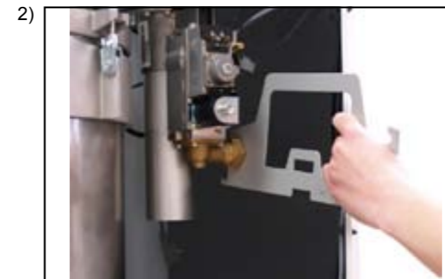
Verschraubung Gasanschluss am Gaskombiventil lösen
