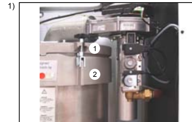
Stecker ①② abziehen (vorher Kreuzschlitzschrauben lösen)
