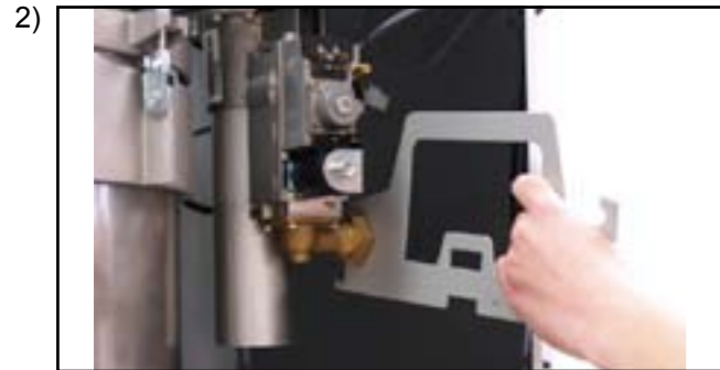
2) Verschraubung Gasanschluss am Gaskombiventil lösen
