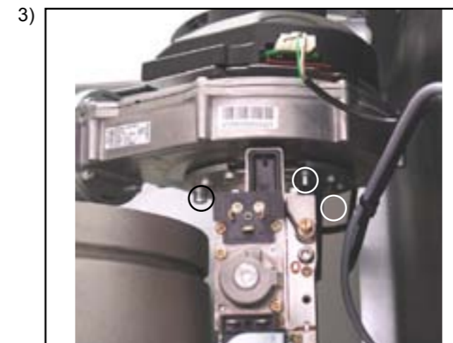
Mischkammer vom Ventilator (3 Stck. Innen-Sechskantschrauben 5mm) abschrauben evtl. Luftansaugrohr abziehen
