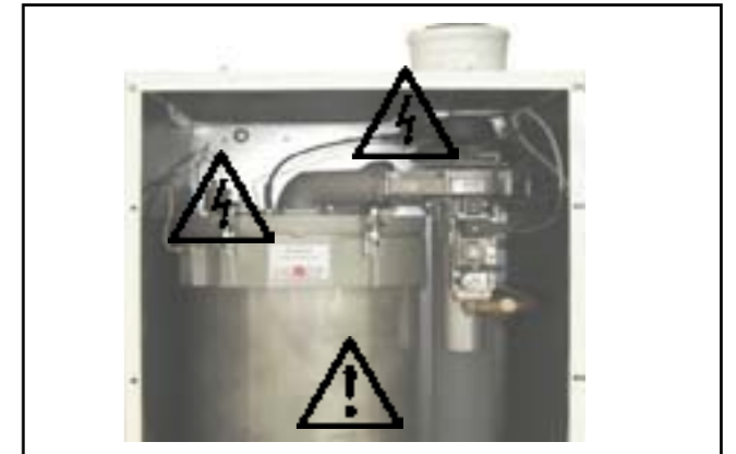
Bild: Zündtrafo, Hochspannungs-Zünderlektrode, Wärmetauscher Gefahr durch elektrische Spannung, Gefahr von Verbrennung durch heiße Bauteile
