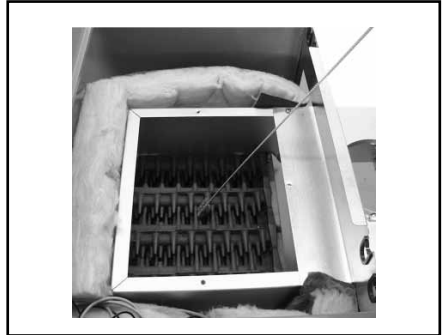
Bild: Reinigung Rauchgaszüge
